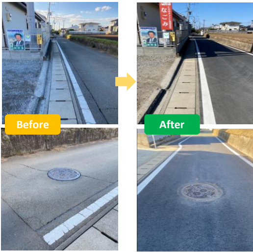
楡木2丁目（市道の補修）
