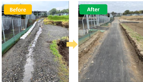
中村発電所前（舗装）
