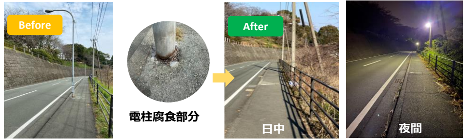
龍田小中間通学路（腐食した電灯の撤去・LED化）
