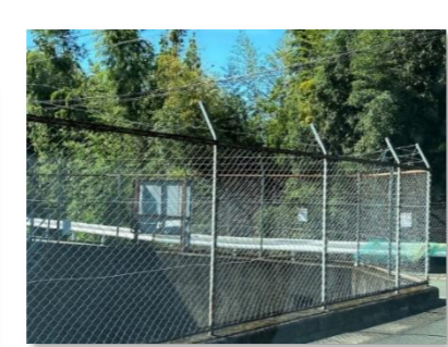
楡木2丁目 （有刺鉄線の破損・垂れ下がり）
