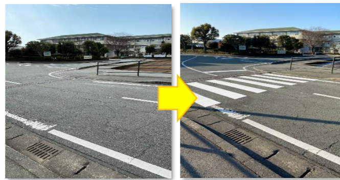
二宮神社前（側溝フタ交換）
