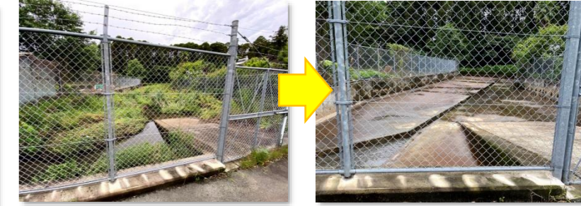
中村発電所前（舗装）
