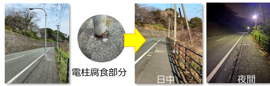
龍田小・中 通学路（腐食した電灯の撤去・LED化）
